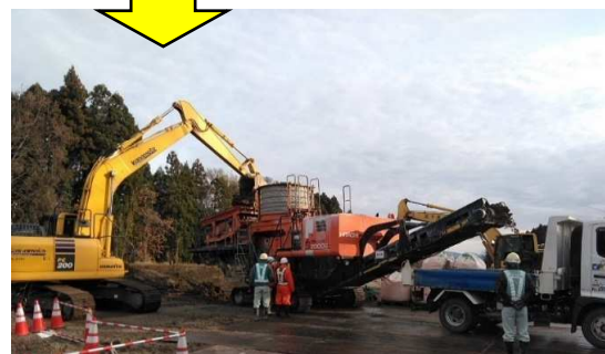
写真1-3. 移動型改良機による土質改良
