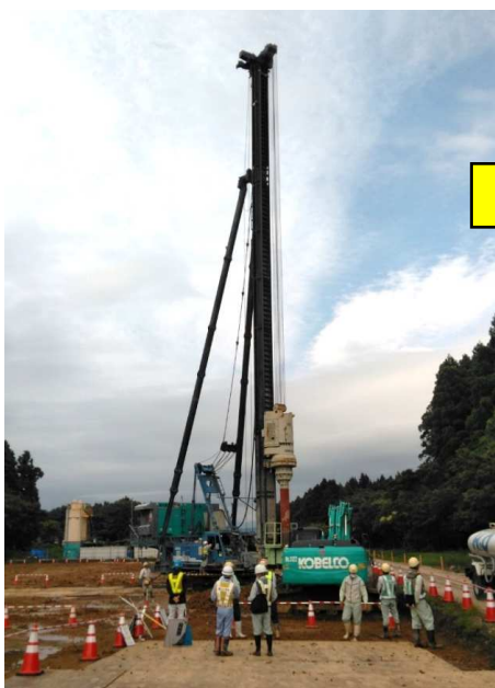
写真1-1. エポコラムによる深層杭造成
