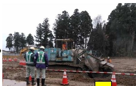
写真1-2. スタビライザー による安定処理
