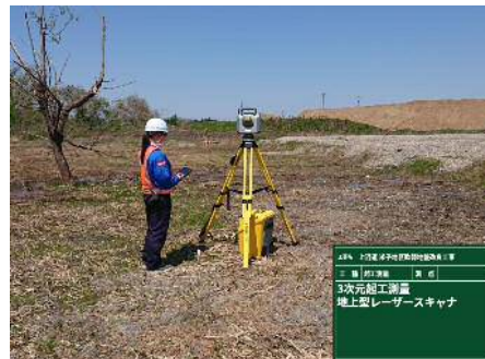
写真-1 【女性技術者によるレーザースキャナ測量】
