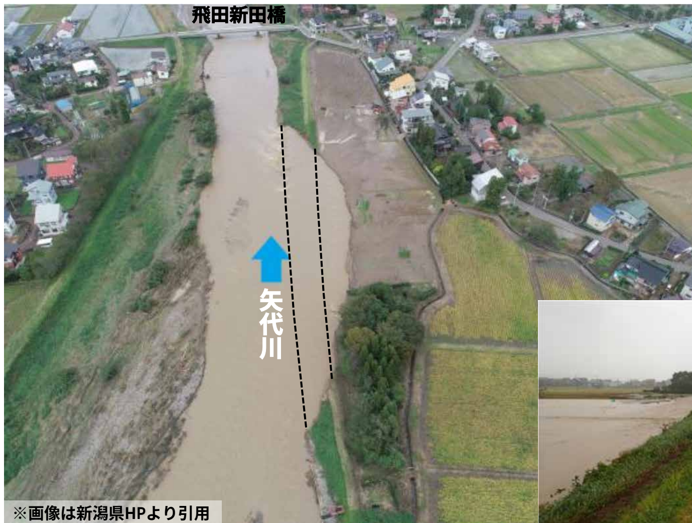
上越市 西田中地内 (堤防侵食による矢代川堤防の決壊)
