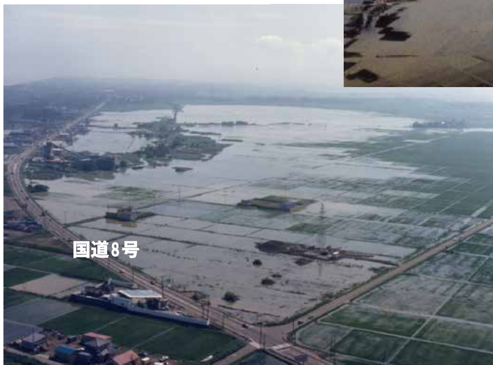
国道8号・頸城入口交差点から 大潟方向
