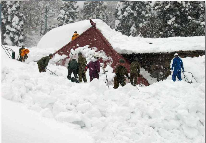
自衛隊による災害派遣活動 によって、雪に埋もれた 家屋の除雪作業がすすめられた。 -妙高市 平成18年2月-
