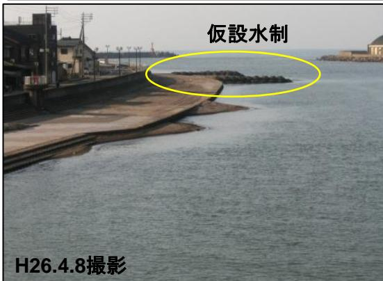
仮設水制試験施工の効果(図-21.3)
