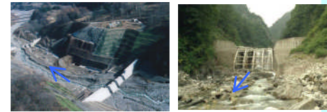
スリット型砂防えん堤(浦川) 鋼製砂防えん堤(松川)
