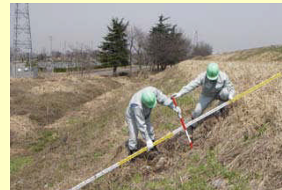
河川管理施設の点検
