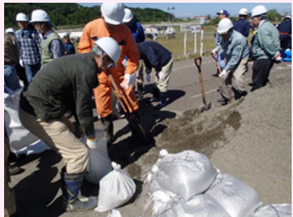
▲水防工法研修
