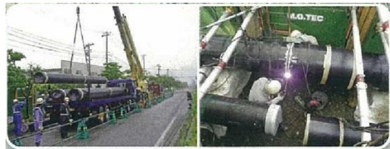
配管・溶接工事
