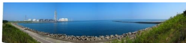
放流口となる日本海側の状況
