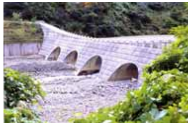
浦川スーパー暗渠砂防堰堤 (H8年着手/H10年完成)
