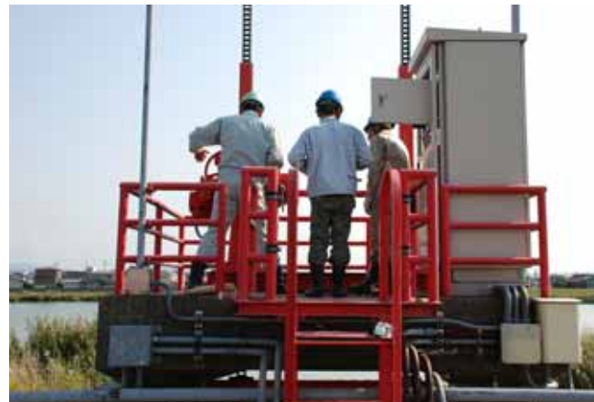
河川管理施設の点検
