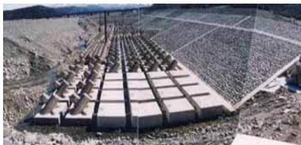
根継護岸の整備状況
