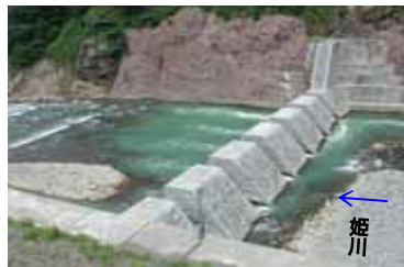
河道スリットダム(本川中流部)
