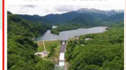
利水ダムの事前放流 (笹ヶ峰ダム・新潟県)
