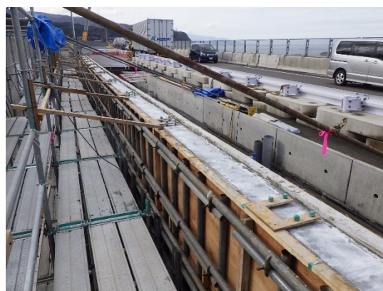
写真-7 塗膜養生剤散布完了
