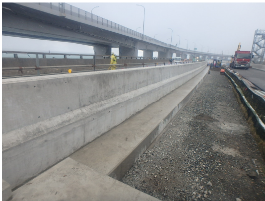
写真-2 壁高欄（過去工事写真）
