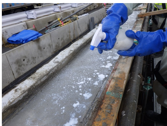
写真-6 塗膜養生剤散布
