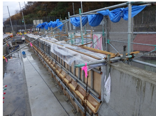
写真-11 コンクリート打設完了
