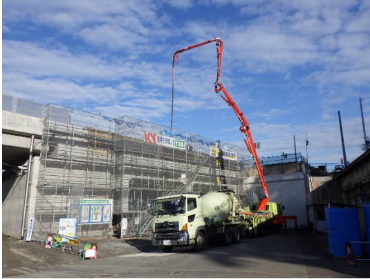
写真-8 コンクリート打設状況
