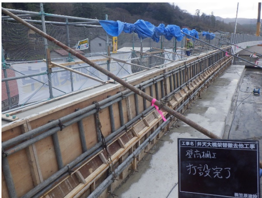
写真-10 コンクリート打設完了
