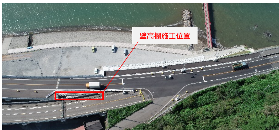
写真-1 壁高欄施工位置
