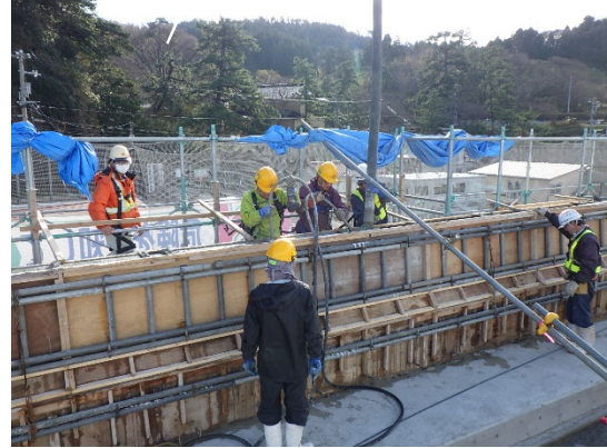
写真-9 コンクリート打設状況
