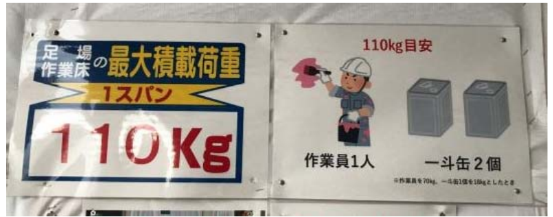
写真-7 足場積載荷重目安表示
