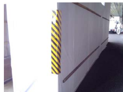
写真-17 反射シート設置
