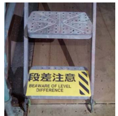
写真-14 段差注意表示②
