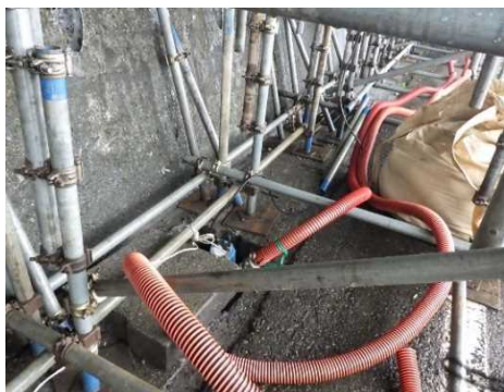
写真-8 側溝での泥水回収
