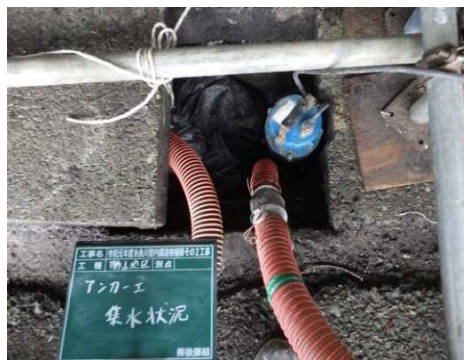
写真-9 濁水回収用ポンプ
