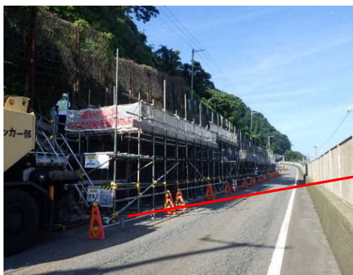
写真-4 足場全景
