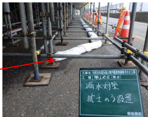
写真-5 枕土のう袋設置
