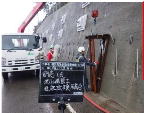
写真-12 性能試験用架台
