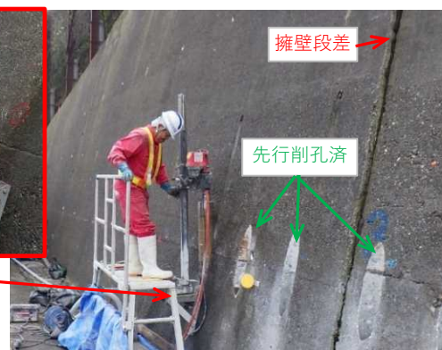
写真-3 先行削孔
