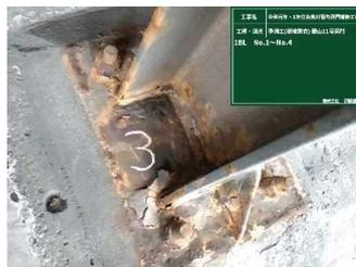
写真-3 ベースプレート モルタル施工部
