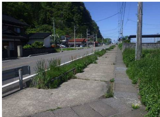
写真-2 現況写真(市振)
