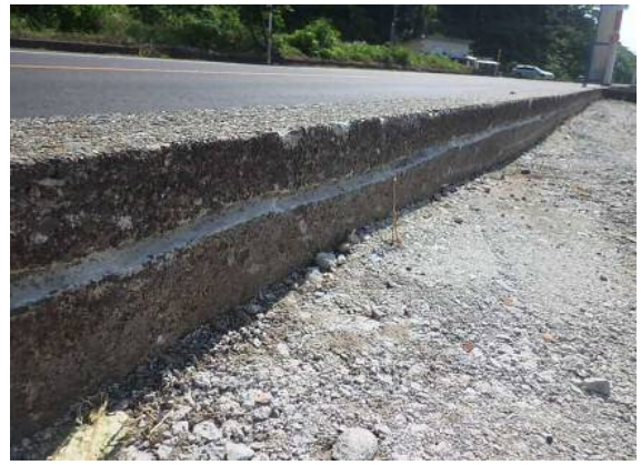
写真-4 切込完了
