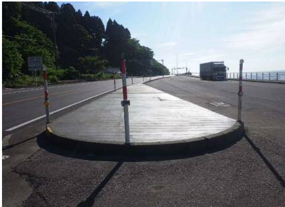
写真-5 打設完了(三段滝)
