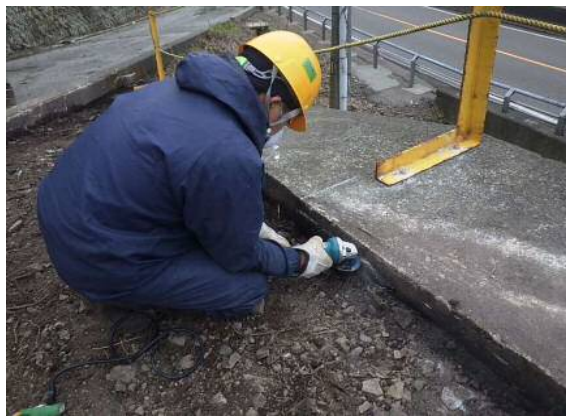
写真-3 施工状況
