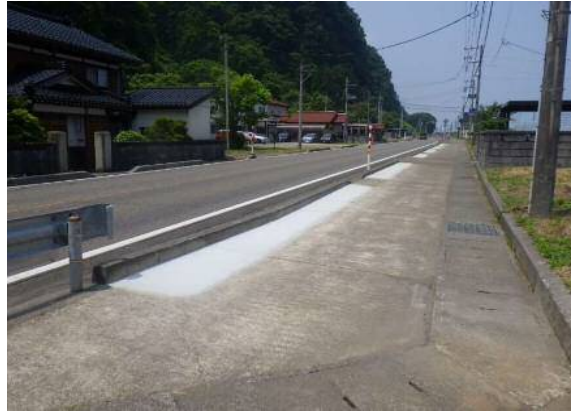
写真-6 打設完了(市振)
