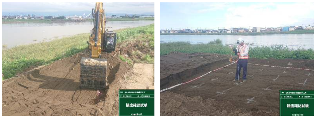
テスト作業による計測精度確認(写真-3)
