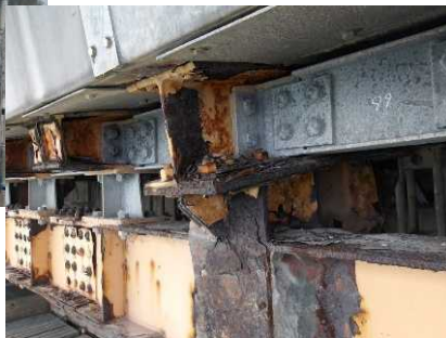
鋼材の腐食
