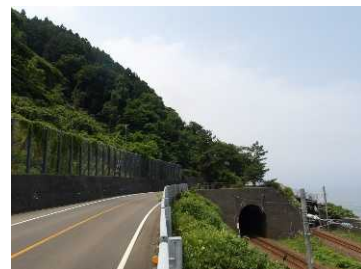
勝山トンネル（写真は東口）
