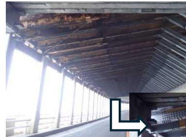
洞門補修の実施状況 左: 補修前 右: 補修後
