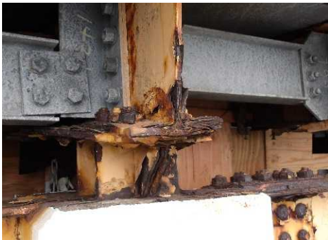
鋼材の腐食
