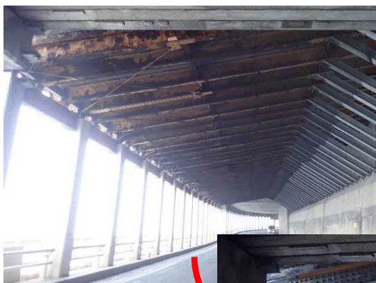
洞門補修の実施状況 上: 補修前 右: 補修後
