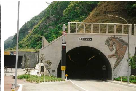
駒返トンネル
