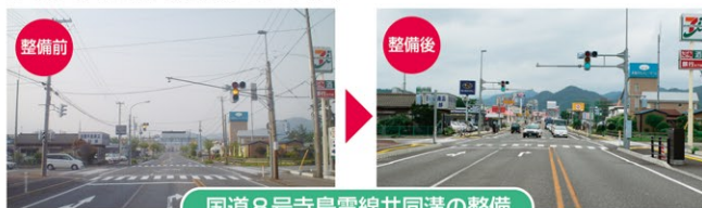
国道8号寺島電線共同溝の整備
