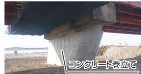
橋脚の補強(国道8号 姫川大橋)
