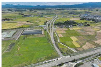
部分開通(H31.3)した上越三和道路
