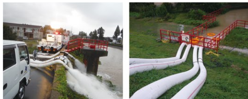
排水ポンプ車による内水排除
