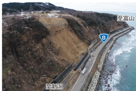
令和6年1月応急復旧完了
