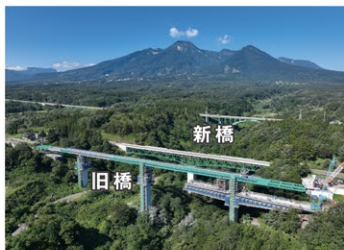
旧橋の撤去状況
