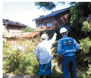
令和6年9月豪雨災害での輪島市被災調査状況
