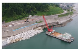
海岸擁壁補修(国道8号 糸魚川市市振地先)
