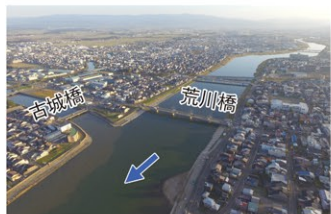
関川・保倉川合流部
