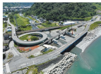
架替工事が進む青海川橋
