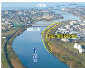
春日・藤野新田地区の河道掘削
