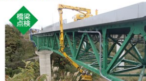
橋梁点検(国道18号 妙高大橋)
