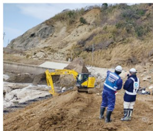
令和6年能登半島地震での輪島市道路啓開作業状況
