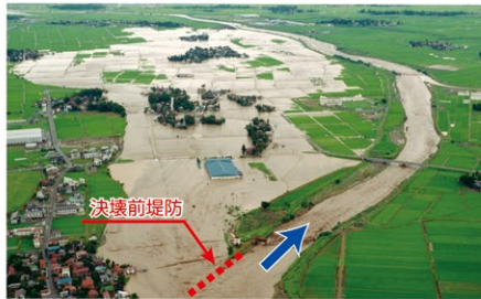
平成7年7月 関川出水 妙高市岡地先堤防決壊状況
