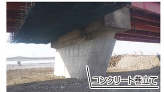
橋脚の補強(国道8号 姫川大橋)
