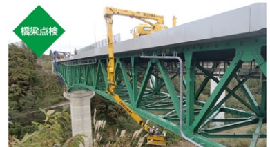
橋梁点検(国道18号 妙高大橋)
