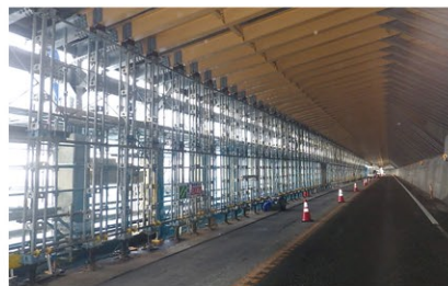
洞門補修(国道8号 糸魚川市市振地先)
