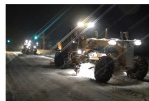
除雪車による除雪状況(国道8号)
