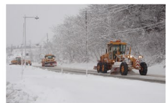
除雪車による除雪状況(国道18号)
