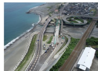
架替工事が進む青海川橋
