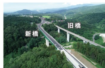
完成した妙高大橋
