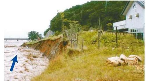
平成7年7月 姫川出水 糸魚川市大野地先 堤防欠損状況
