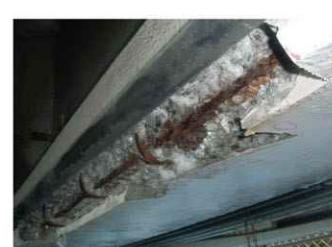
主柱の損傷状況(青海川橋)
