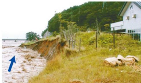
平成7年7月 姫川出水 糸魚川市大野地先 堤防欠損状況
