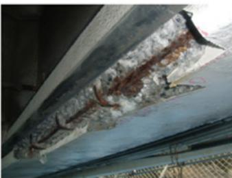
主桁の損傷状況(青海川橋)
