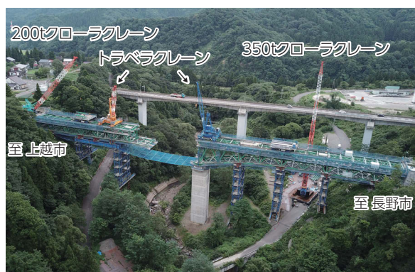
トラス桁の架設
