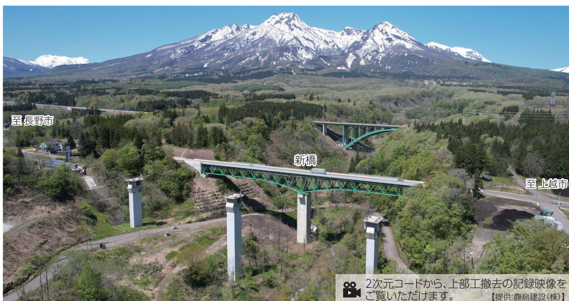
旧橋の上部工撤去完了
