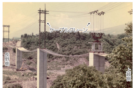
基準ブロックの架設 1971年(昭和46年)
