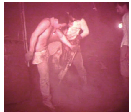
地下28mのケーソン内部での掘削作業 1971年(昭和46年)
