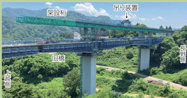
架設桁の送り出し
