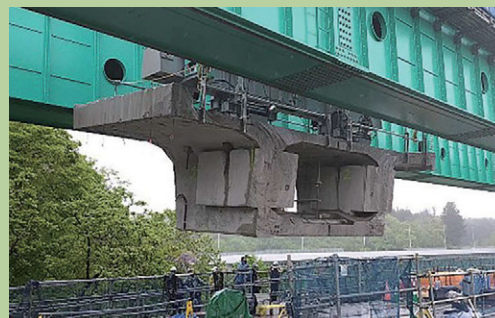
吊り装置で撤去ブロックを移送
