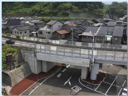
筒石橋 (新潟側径間) (抜本対策として、橋梁のボックス化対策を実施)
