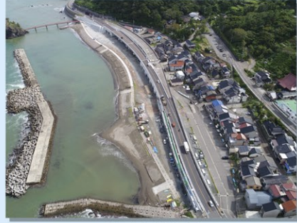
弁天大橋全景 (H31.3に新橋へ交通切替え)
