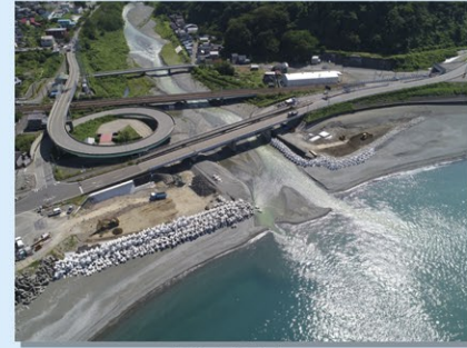
青海川橋全景
