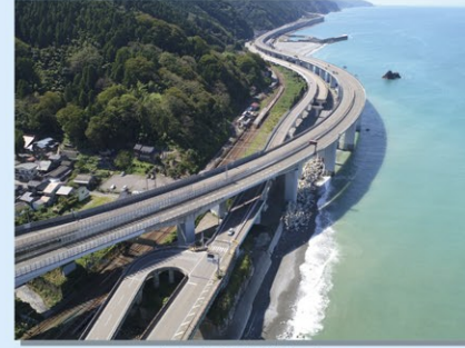
歌高架橋全景 (H29.3に新橋へ交通切替え)
