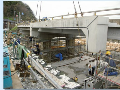
大断面ボックスカルバート引き込み作業 (H22.7)
