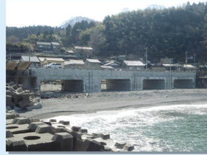
両鬼橋 (架替方法として橋梁のボックス化対策を実施) (H23.3完)
