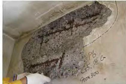
主桁の損傷状況(弁天大橋)
