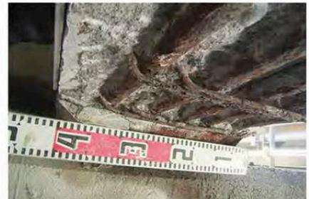
内部鉄筋の腐食状況(断面欠損)(境橋)
