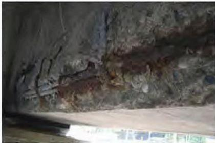
主桁の損傷状況(歌高架橋)
