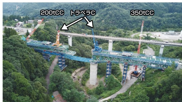
令和2年8月 トラス桁架設状況
