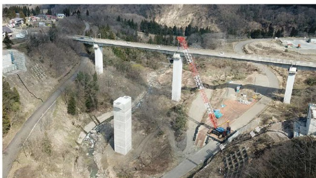
令和2年4月 橋台・橋脚施工完了
