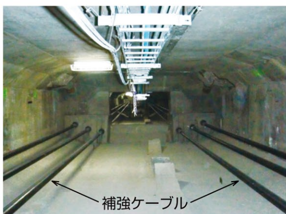
桁の中の補強ケーブル設置状況
