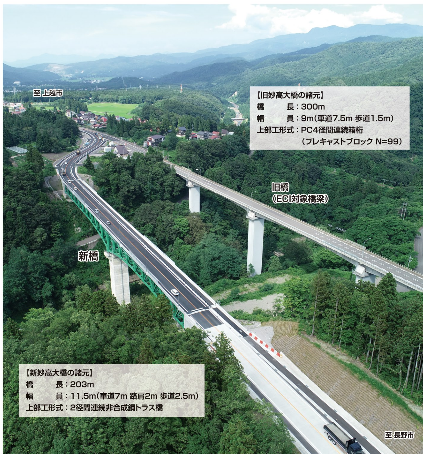
新しく開通した妙高大橋と旧橋
