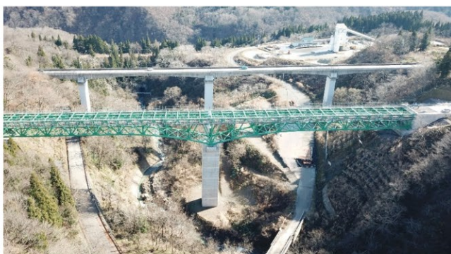
令和2年11月 トラス桁架設完了
