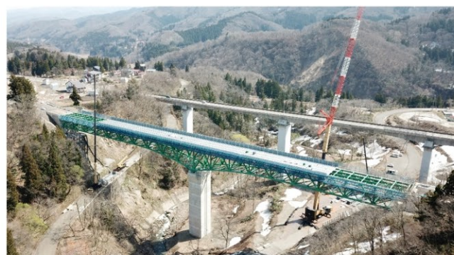
令和3年4月 合成床版架設状況
