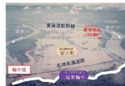
岐阜県輪之内町（福東輪中）
