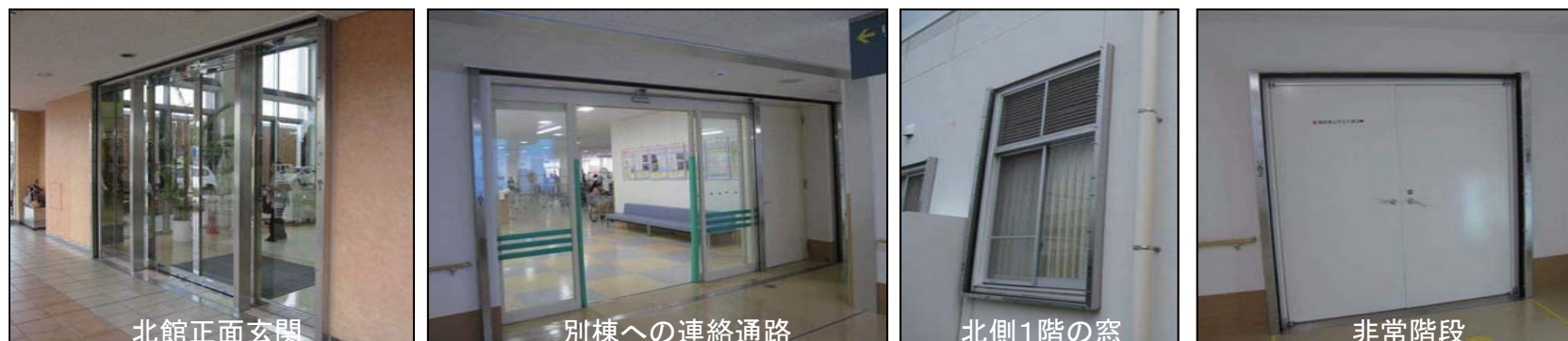
止水板のための角落し設置
