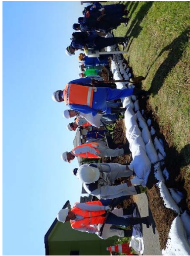
●市民積み土のう工－土のう制作作業
