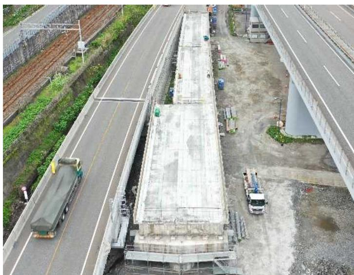
(橋面) アスファルト舗装撤去完了
