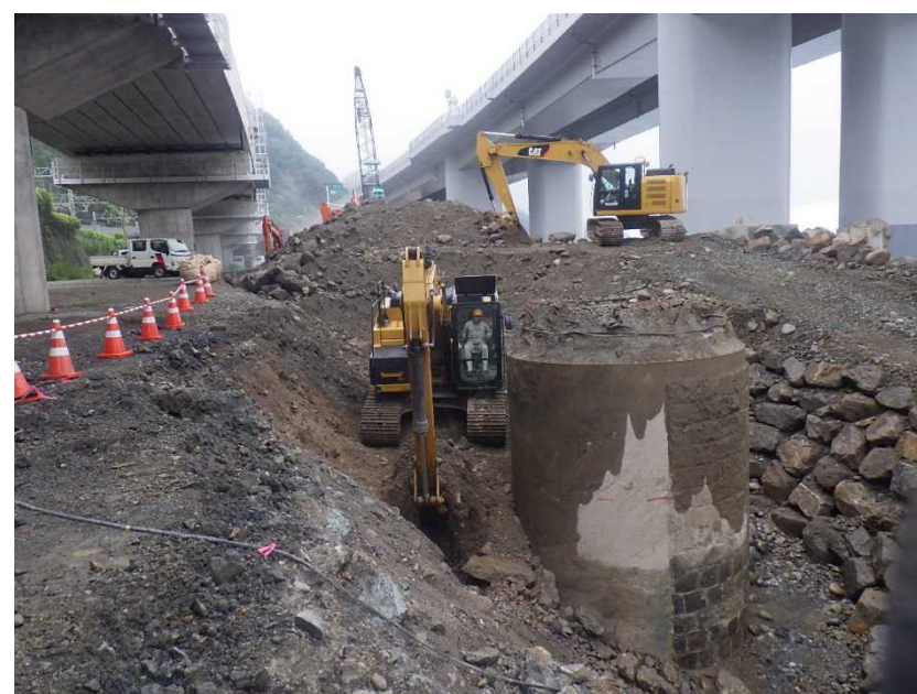
【 P17掘削状況 】
