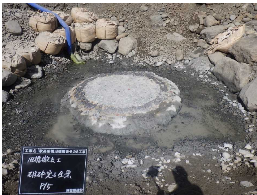
【 P15破砕完了全景 】
