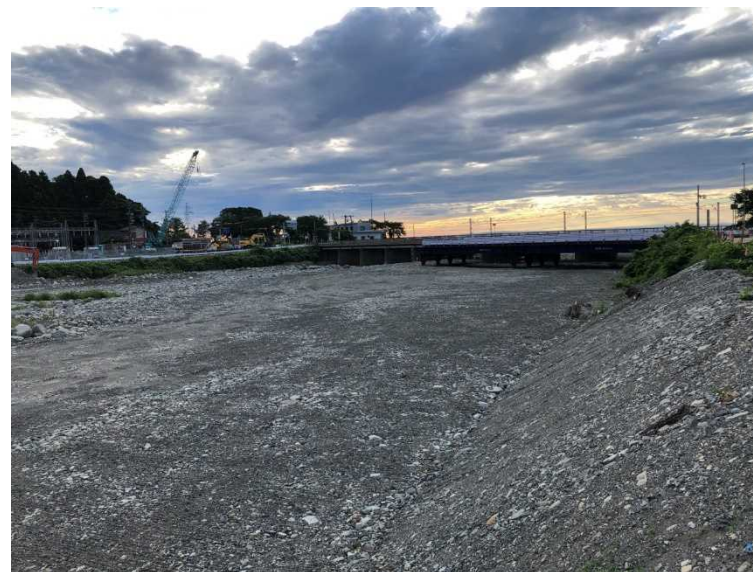
仮締切撤去完了
