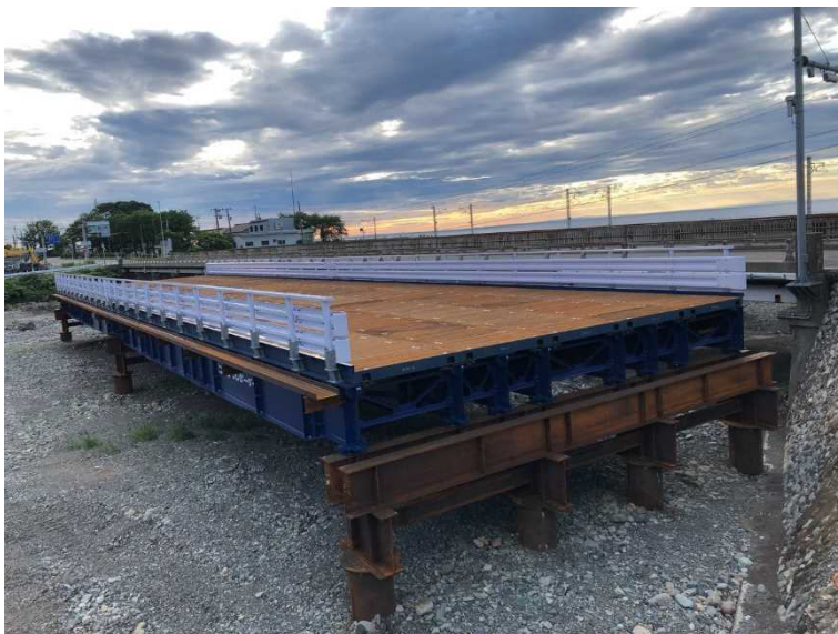
仮橋 KP1-KP3まで完了 (起点側から終点側を望む)
