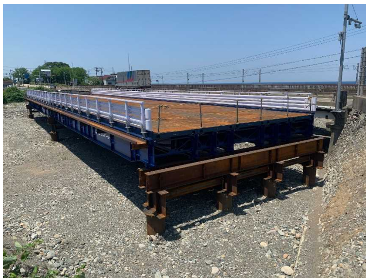
仮橋 KP1-KP3まで完了 (起点側から終点側を望む)
