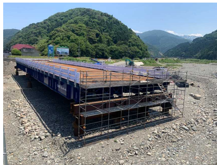
仮橋 KP1-KP3まで完了 (終点側から起点側を望む)
