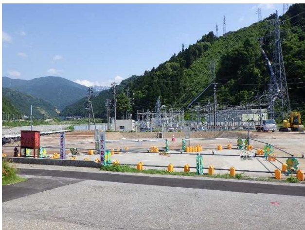
境橋富山側(A2側県道迂回路)海側より望む
