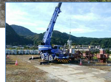
【コンクリート打設】
