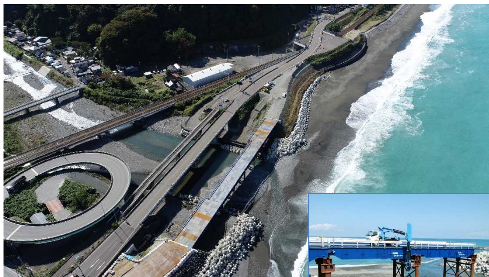
【施工箇所全景 東より望む】
