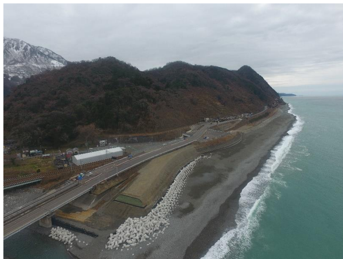
【施工箇所全景 東より望む】
