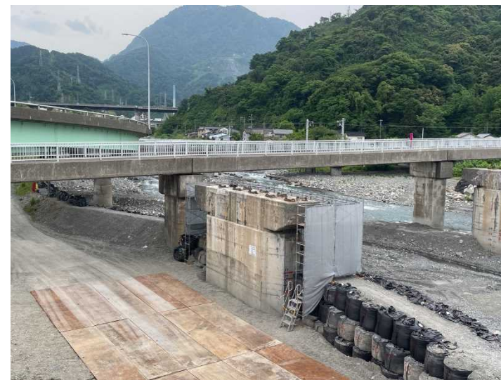
施工箇所近景 （下流から上流を望む）
