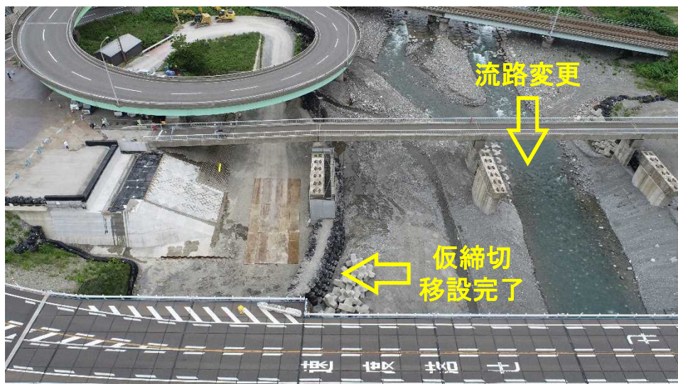
施工箇所遠景 （下流から上流を望む）
