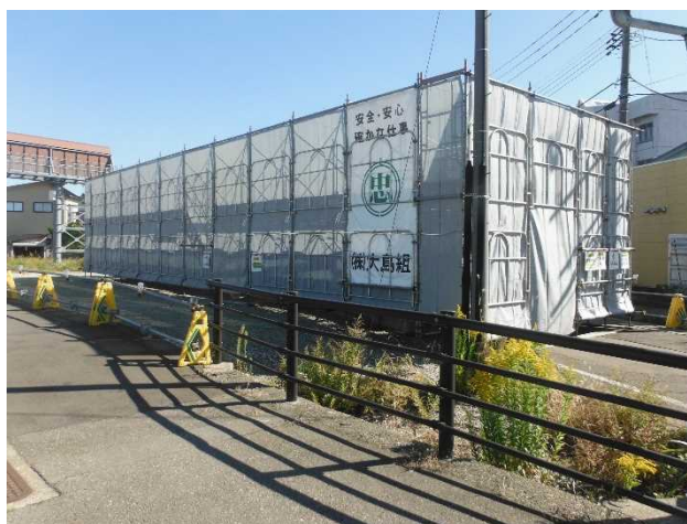
【 地下道上屋(下り) 足場組立設置 】
