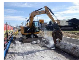
【 構造物取壊し状況 】
