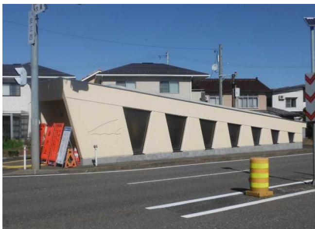
【 既設地下道(上り) 補修完了 】
