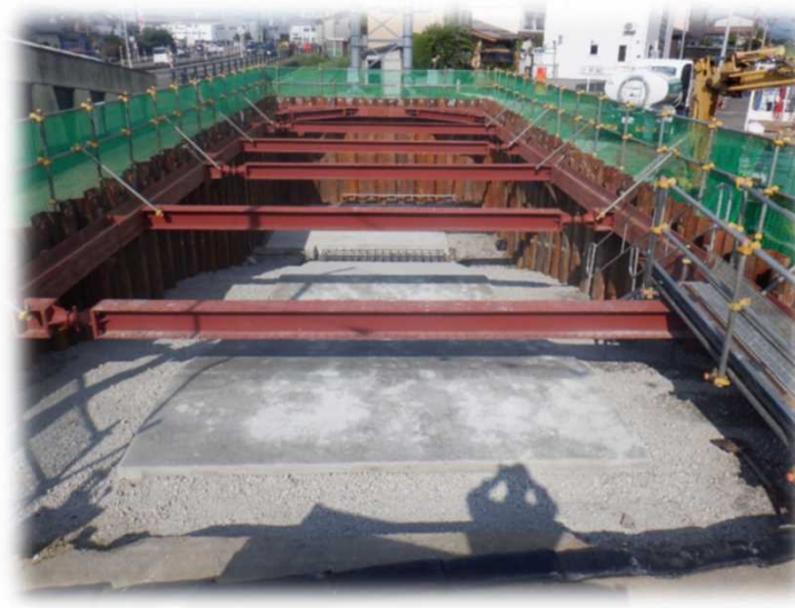
【均しコン打設 枕工鉄筋組立完了】
