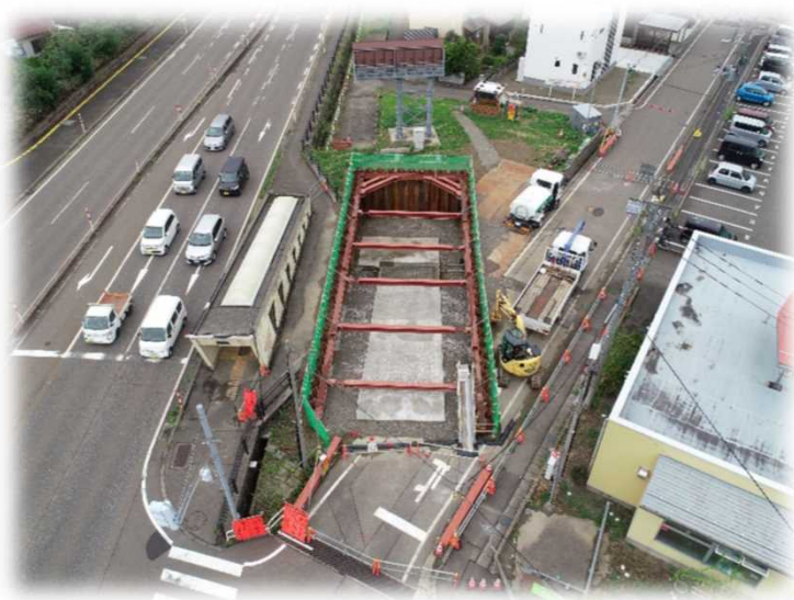
【一期施工箇所 鋼矢板圧入】
