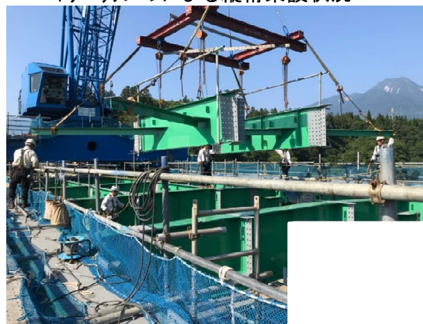
【鋼橋架設工_A1側】 トラバークレーンによる縦桁架設状況
