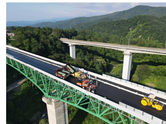
橋梁部 舗装工 施工状況
