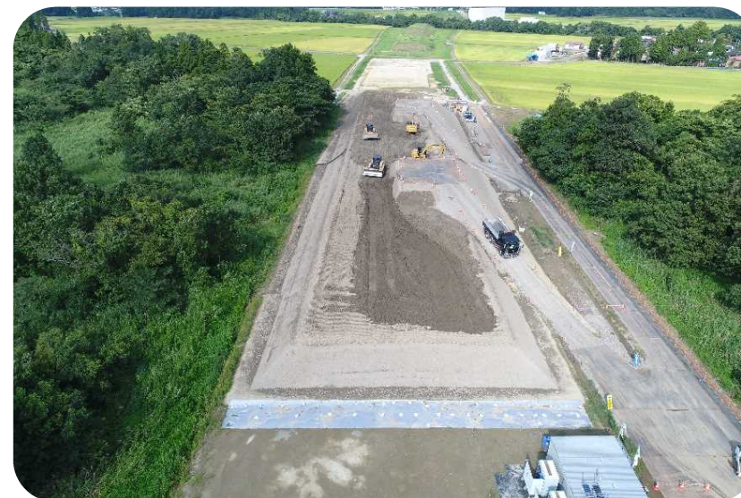
《 3工区 路体盛土工進捗全景 》
