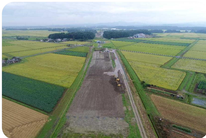
《 1工区 路体盛土工着手前全景 》
