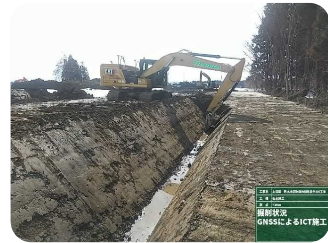
《 仮水路工 ICT施工による掘削状況 》
