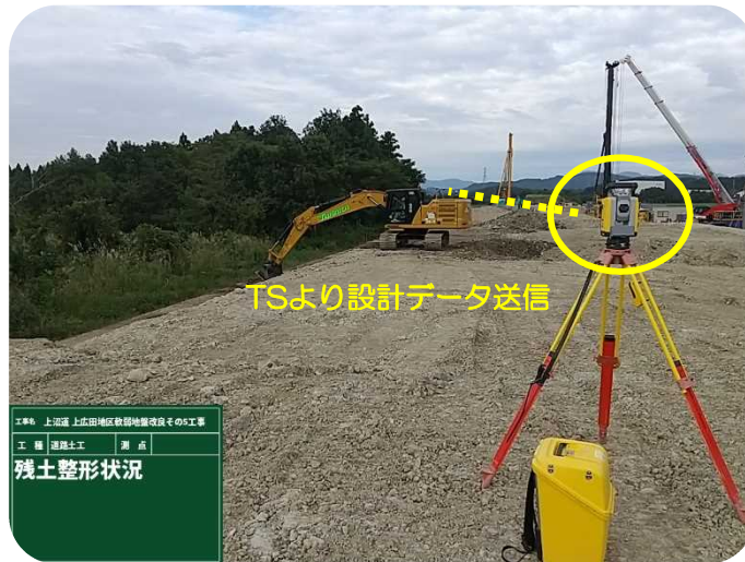
【TS-MCバックホウによる整形状況】
