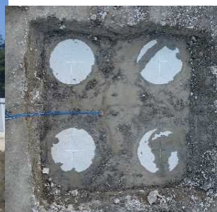
出来形確認状況
