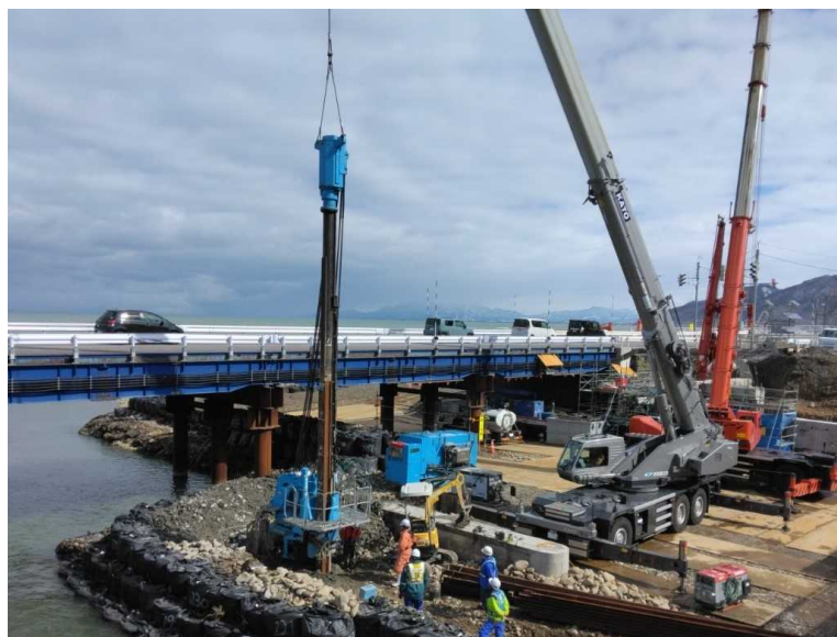
【鋼矢板土留 施工状況】
