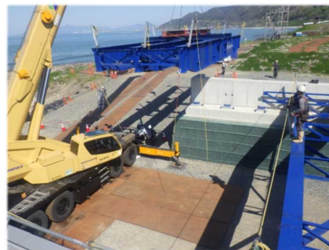
右岸側 上部工 架設状況
