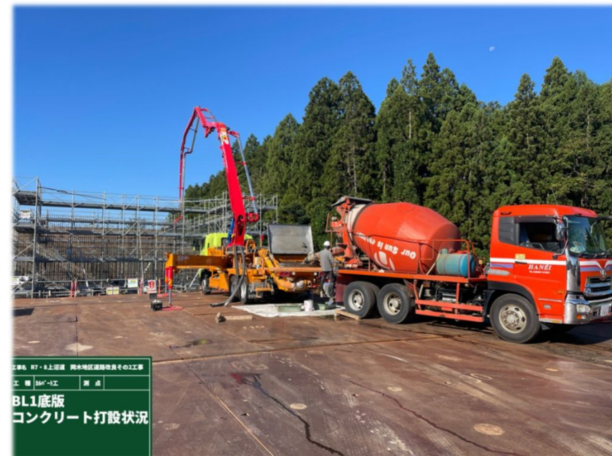
底版コンクリート打設状況
