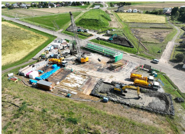
【場所打杭工】 掘削状況
