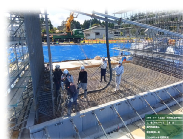
底版部(BL-1) コンクリート打設
