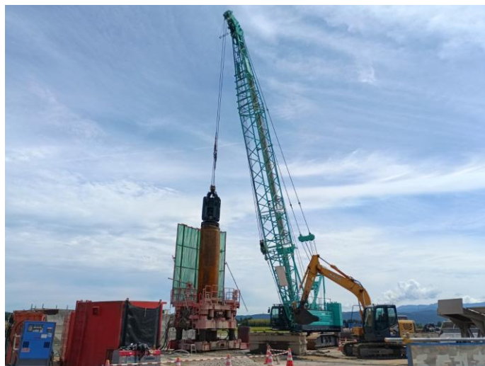
【場所打杭施工状況】
